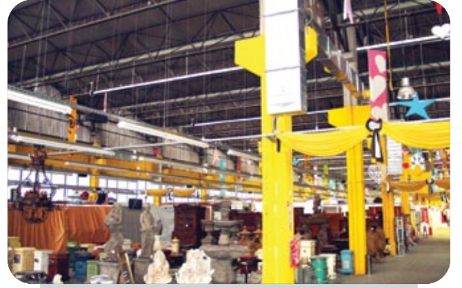
Fuar Alanı Uygulaması: Düz Tip Çok Yakıclı Sistem - Genel Isıtma
