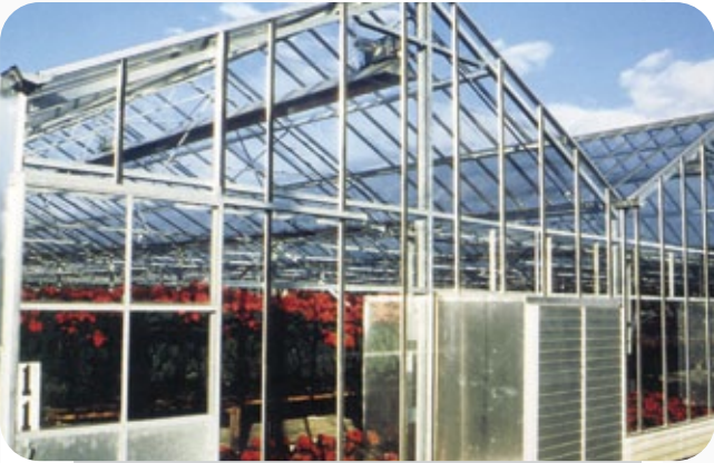
Sera Uygulaması: Seri Yakıclı Sistem - Genel Isıtma
