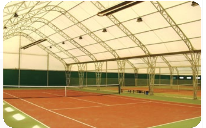
Tenis Kortu Uygulaması: U Tip Üniter Sistem – Genel Isıtma
